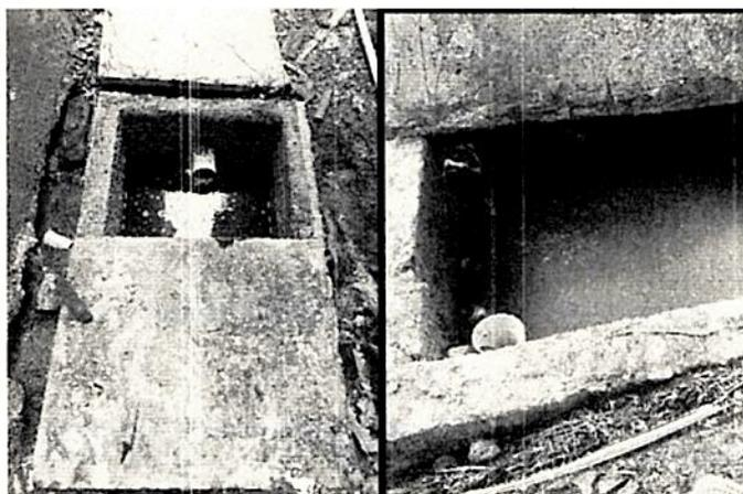
Foto N° 3. Caja de inspección y estructura de entrada al tanque séptico.
