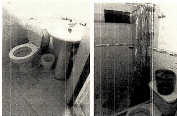
Foto N° 2. Unidad sanitaria tipo de cada habitación
