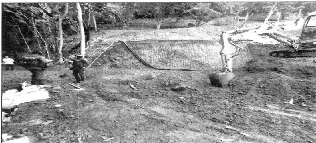
Fotografía 1. Vista general de la excavación y explanación No. 1
