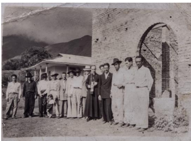
Figura 63. Construcción de la iglesia católica.
