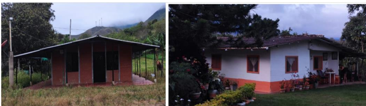
Figura 52. Viviendas prefabricadas y en madera, DRMI ES de Atuncela y su área de ampliación.
