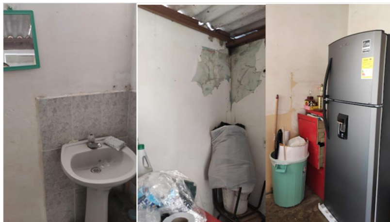
Figura 49. Instalaciones internas de la Sede Educativa Rosa Zarte de Peña.
