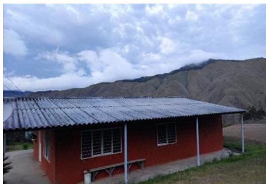
Figura 51. Vivienda construida en mampostería, DRMI ES de Atuncela y su área de ampliación.
