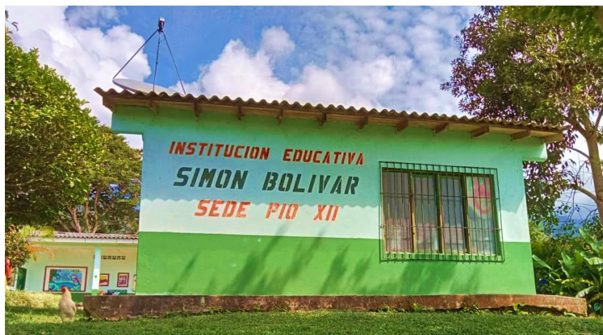
Figura 37. Infraestructura vereda El Vergel: Escuela
