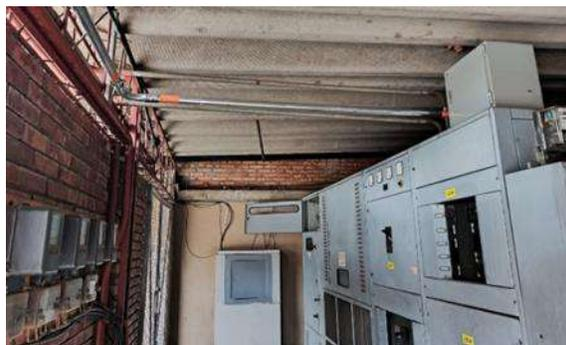
Foto 69. Instalación acometida eléctrica para aires acondicionados Archivo Central.
