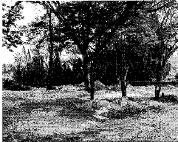
Ilustración 6. MATERIAL DE RÍA ACUMULADO AL SUR DEL PREDIO CON EXPLANACIÓN AFECTANDO RAÍCES DE LOS ÁRBOLES EN LA FFP DEL RÍO LA VIEJA. DANIEL H. CVC 2024
