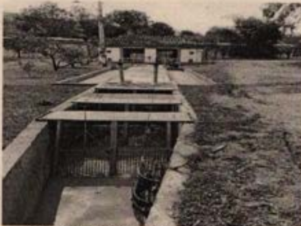
Foto 1 y 2: Panorámica estructura de entrada a planta y localización de compuertas de operación manual
