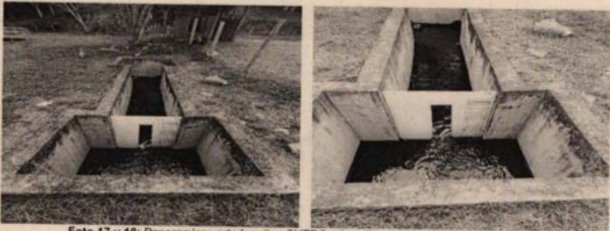
Foto 17 y 18: Panorámica vertedero tipo SUTRO a la salida del agua residual de la PTAR
