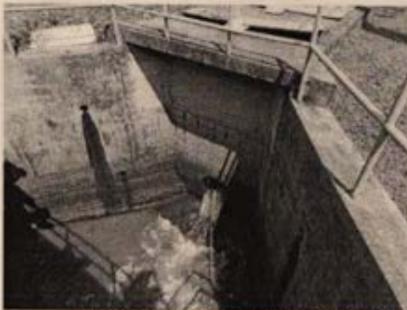
Foto 3 y 4: Panorámica ingreso del agua residual al tanque de bombeo hacia los reactores UASB
