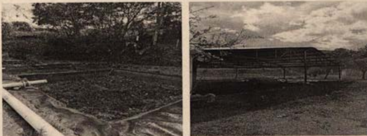
Foto 7 y 8: Panorámica lechos de secado de los Reactores UASB
