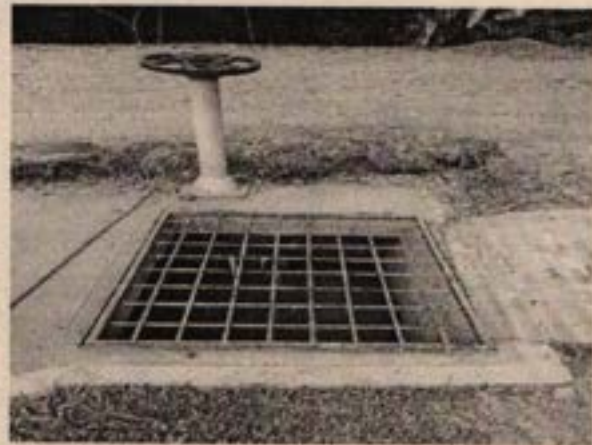
Foto 1 y 2: Panorámica estructura de entrada a planta y localización de compuertas de operación manual
