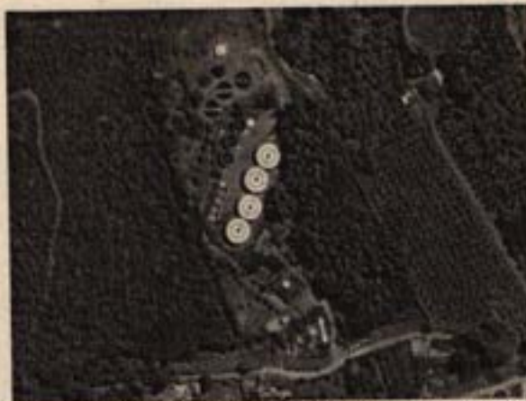
Imagen 2: Panorámica PTAR La Camelia. Fuente: Google
