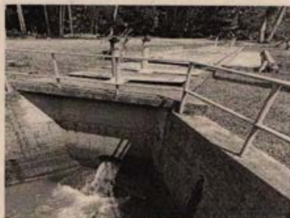
Foto 3 y 4: Panorámica ingreso del agua residual al tanque de bombeo hacia los reactores UASB
