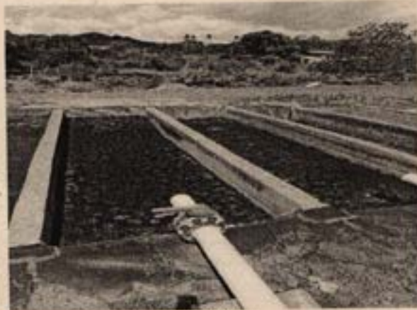
Foto 13 y 14: Panorámica lechos de secado de los sedimentadores
