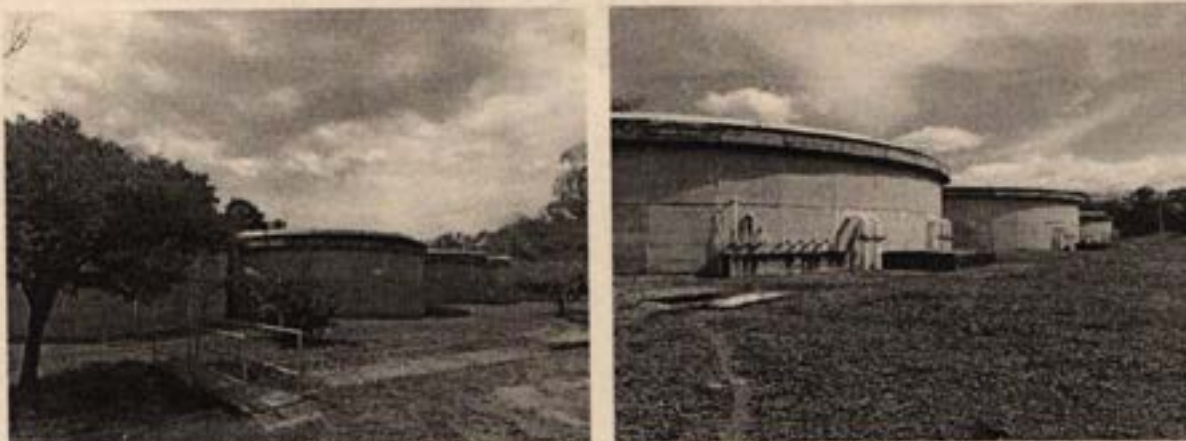
Foto 5 y 6: Panorámica reactores anaerobios de flujo ascendente UASB
