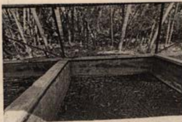
Foto 26 y 27: Panorámica lechos de secado para los lodos generados por terceros
