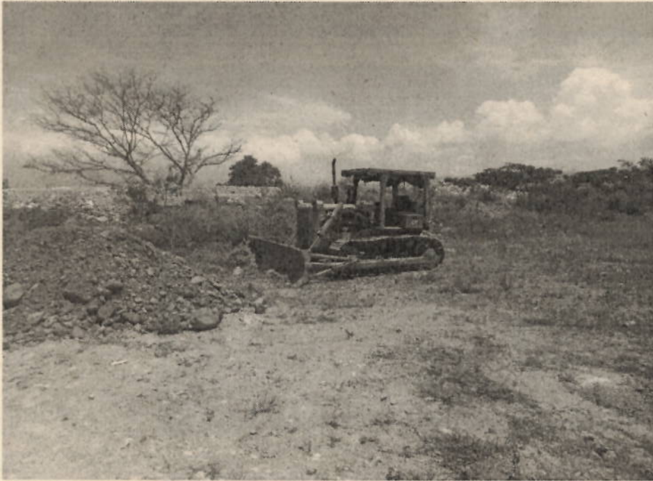
Pozos agua subterránea
