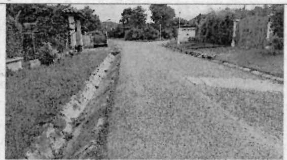
Obras de arte para vías.
