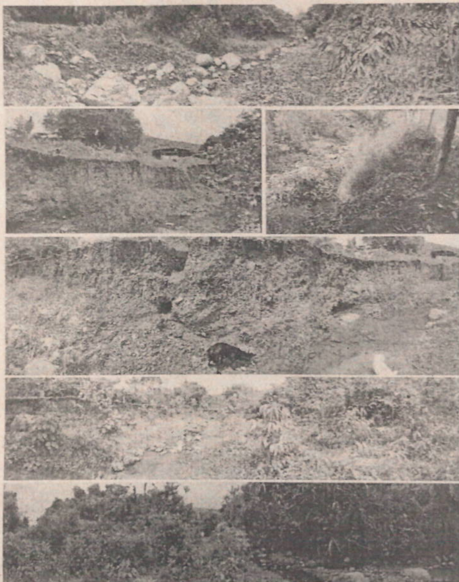
Figura: Tramo del cauce seco por la desviación de la quebrada Los Negros y erosión del terreno
