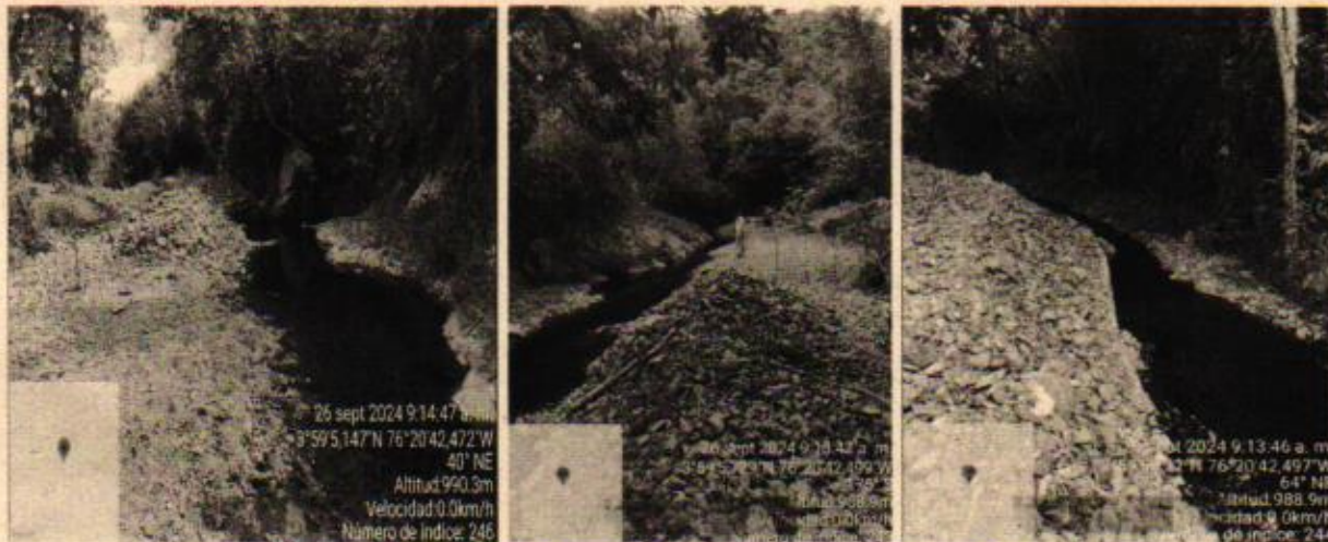
Imágenes 4, 5 y 6: desvío del cauce de la quebrada La Negra.
