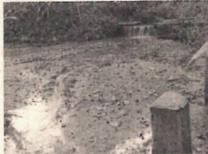
Figura 3. Acumulación de sedimentos, PTAR El Llanito.
