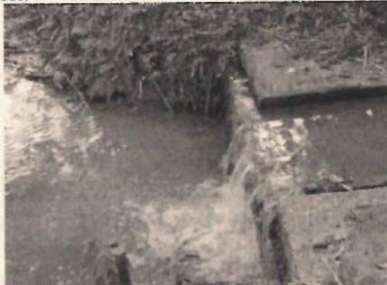
Figura 2. Rebose de las aguas residuales, PTAR El Llanito.
