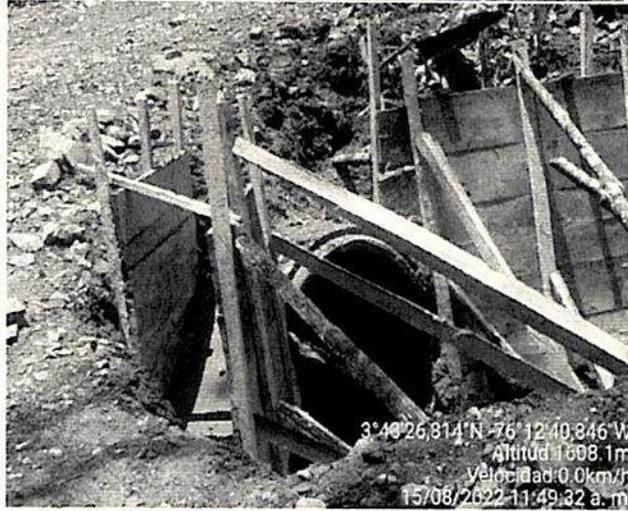
Obras de arte tipo alcantarillas ubicadas sobre los cauces de mayor caudal, actividad realizada dentro del mejoramiento que se adelanta.
