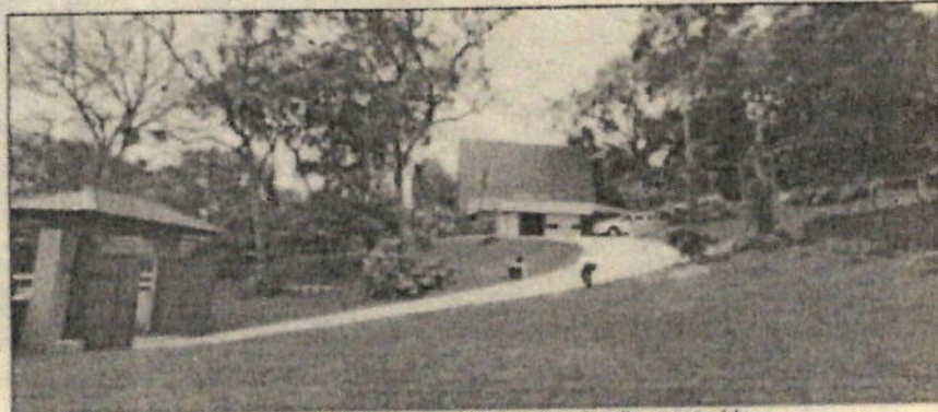
Fotografía 6. Vista general de la placa huella construida.
