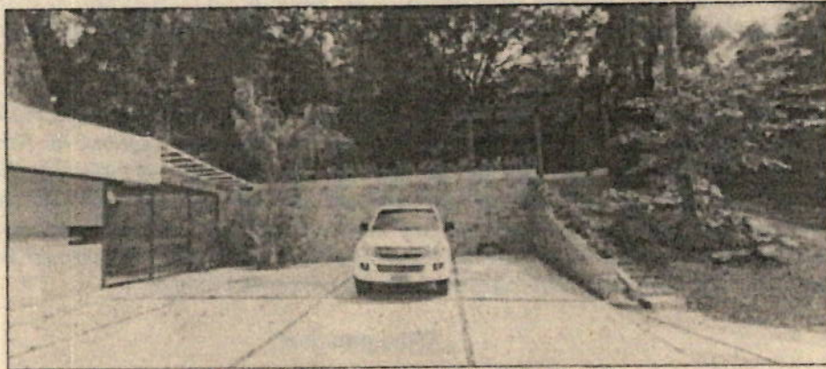
Fotografía 2. Vista del talud conformado con muro.
