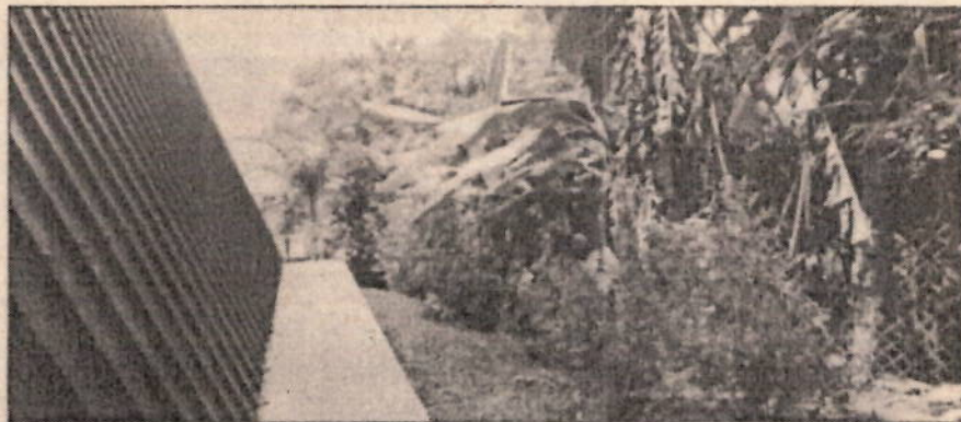
Fotografía 4. Vista del lateral con ocupación de área forestal protectora de fuente hídrica.
