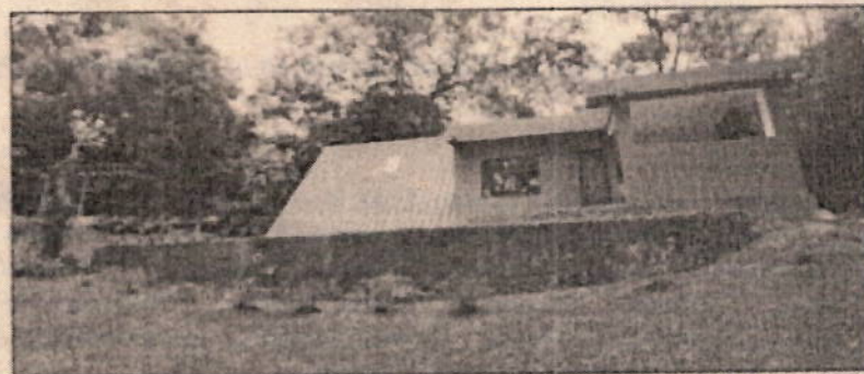
Fotografía 6. Vista general de la casa 2 y muro de contención para la adecuación de terreno realizada.
