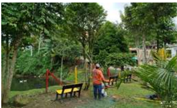
Foto 175. Mantenimiento arbóreo y de zonas verdes aledañas al humedal. Archivo CVC, 2024
