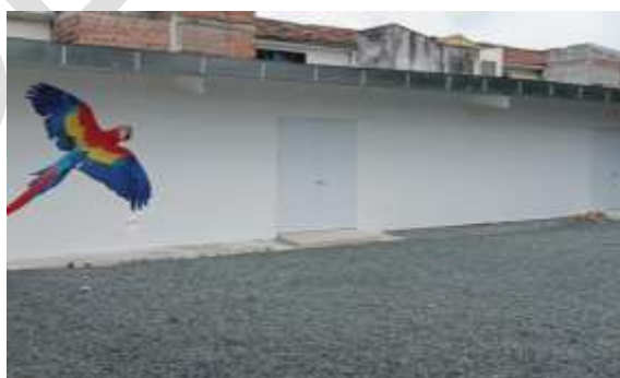
Foto 153. Bodega Archivo Central. Vista exterior. Archivo CVC, 2024
