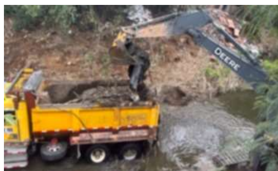
Foto 131. Retiro de sedimentos a máquina en el río Cali. Archivo CVC, 2024
