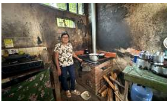
Foto 170. Instalación de la estufa de la señora Consuelo Velásquez García. Archivo CVC, 2024
