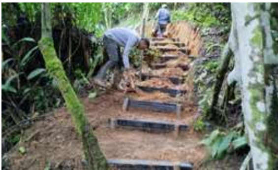
Foto 173. Arreglo general ecosendero, escalinatas y pasamanos con madera plástica. Archivo CVC, 2024
