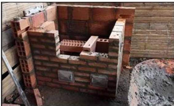
Foto 122. Instalación de estufa ecoeficiente. Archivo CVC 2024
