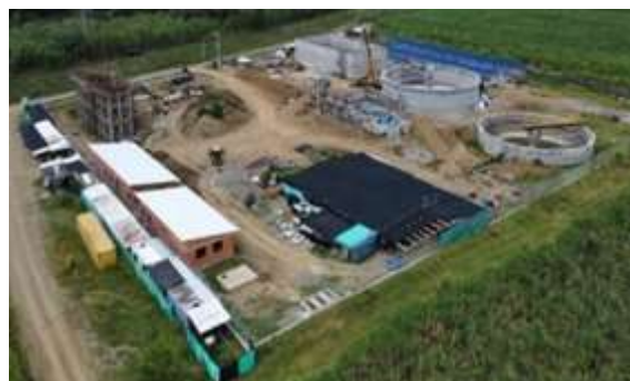
Foto 85. Construcción de la PTAR de la cabecera municipal de Zarzal. Archivo CVC, 2024
