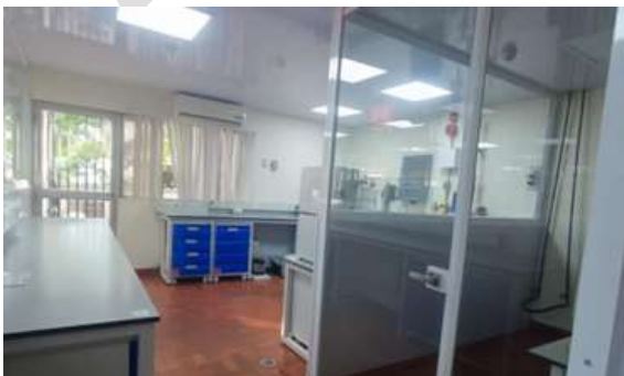
Foto 148. Reemplazo divisiones Laboratorio Ambiental. Detalle 1. Archivo CVC, 2024
