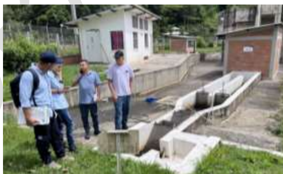
Foto 99. Visita de inspección ocular planta de tratamiento de aguas residuales centro poblado Salónica, municipio de Riofrío. Archivo CVC, 2024
