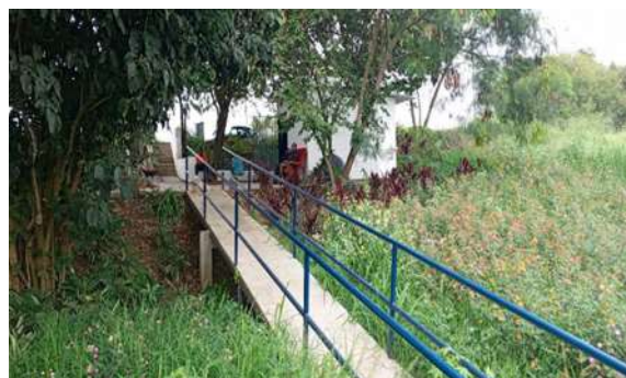
Foto 68. Adecuación ornamental y rampa Embarcadero Barco Escuela Cali. Archivo CVC, 2024
