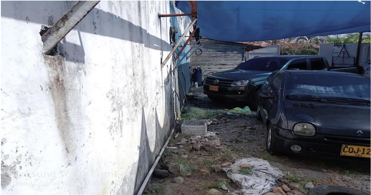
Foto No. 3. Instalaciones y tubería que provienen del aljibe.
