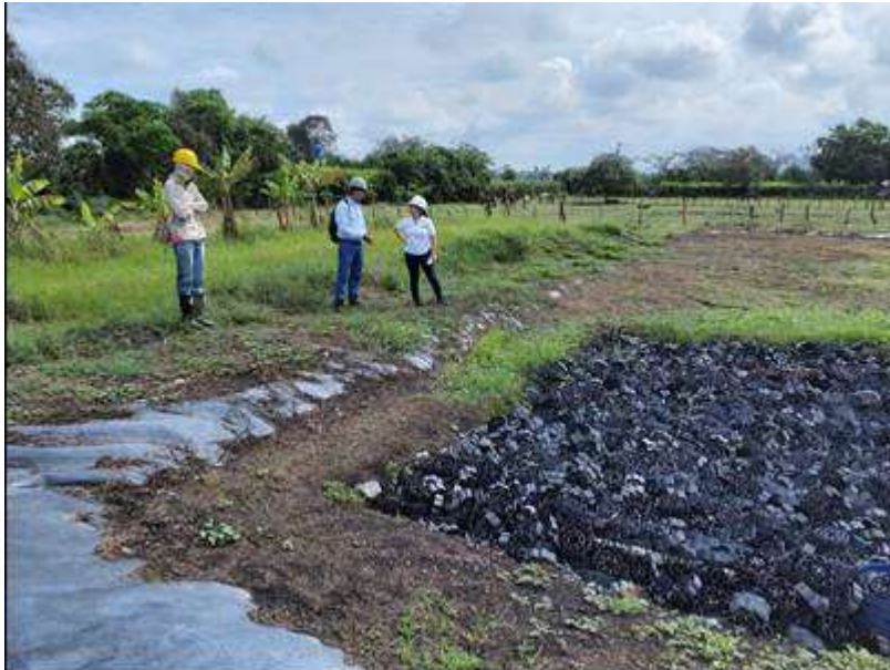
Foto 8. Inspección del Filtro anaeróbico o laguna sub superficial de flujo ascendente.
