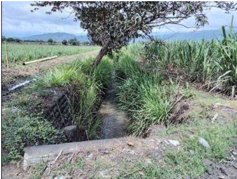
Foto 11. Canal de drenaje con rumbo a la acequia Zanjón de Piedra.
