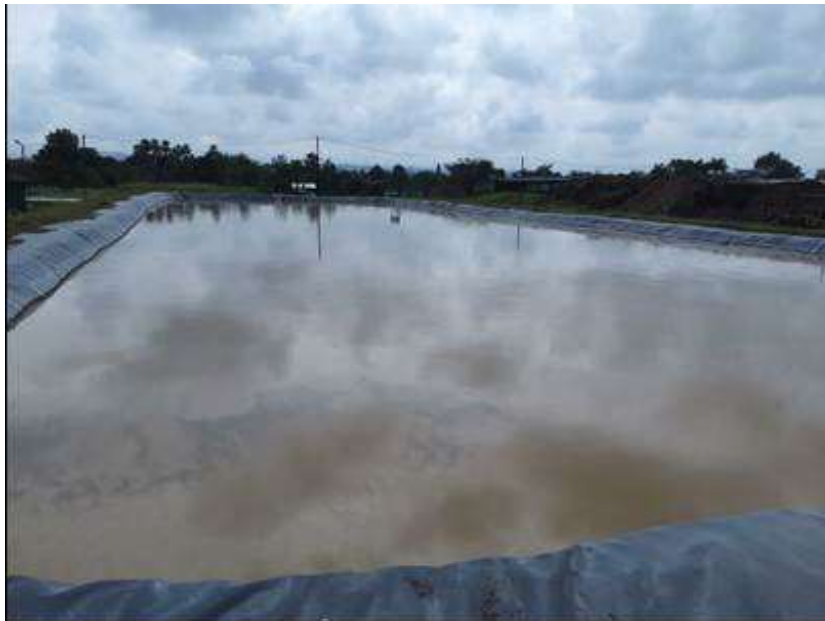
Foto 2. Laguna anaeróbica.
