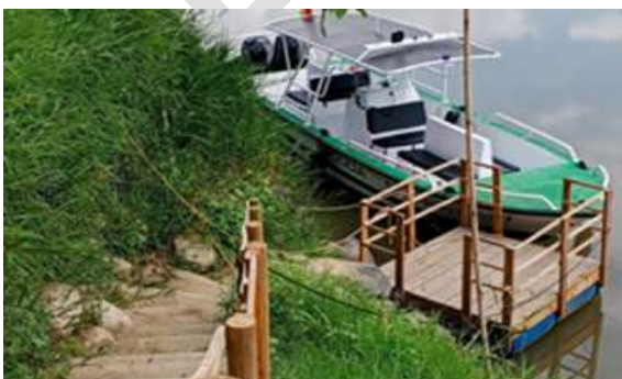
Foto 67. Adecuación acceso embarcadero Barco Escuela. Archivo CVC, 2024
