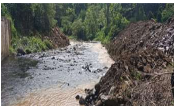
Foto 114. Descolmatación Río Lindo – Municipio Riofrío. Archivo CVC, 2024
