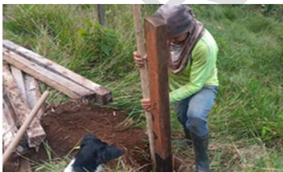
Foto 37. Aislamiento de protección - Predio Cedritocuenca Morales, vereda La Iberia, municipio Andalucía, antes. Archivo CVC, 2024
