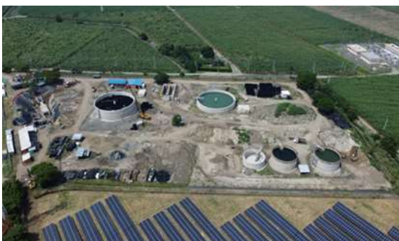
Foto 82. Construcción de la PTAR corregimientos El Carmelo, San Joaquín, Villagorgona y Buchitolo en el municipio de Candelaria. Archivo CVC, 2024
