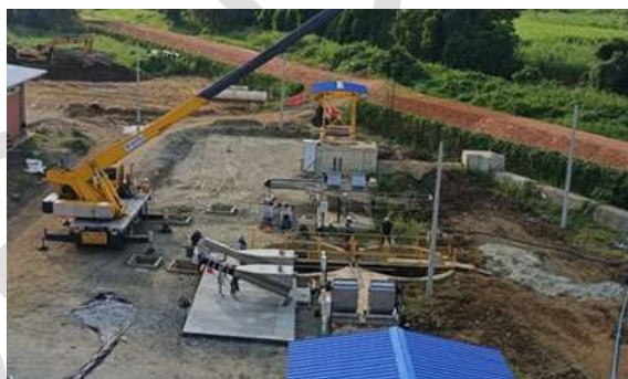
Foto 83. Construcción de la PTAR de la cabecera municipal de Jamundí. Archivo CVC, 2024
