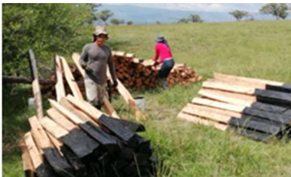
Foto 33. Aislamiento de protección predio Buenos Aires, cuenca Tuluá - municipio de Tuluá - Vereda Mateguadua. Archivo CVC, 2024
