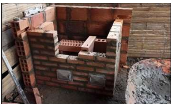
Foto 122. Instalación de estufa ecoeficiente. Archivo CVC 2024
