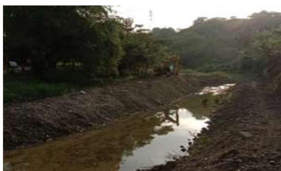
Foto 115. Descolmatación Quebrada Artieta – Municipio de San Pedro. Archivo CVC, 2024
