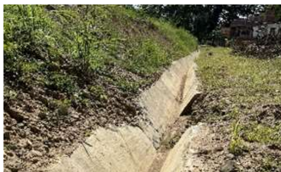
Foto 111. Descolmatación canal de aguas lluvias, barrio Los Cámbulos, municipio de Cartago. Archivo CVC, 2024
