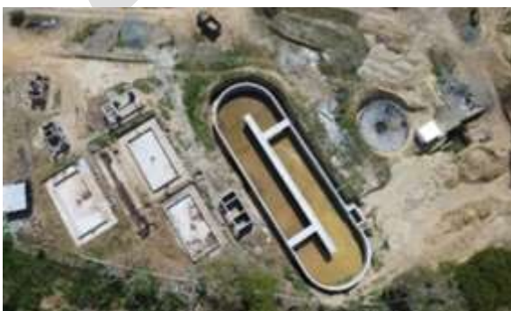
Foto 84. Construcción de la PTAR de la cabecera municipal de El Dovio. Archivo CVC, 2024
