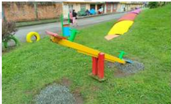
Foto 174. Mejoramiento de la infraestructura del parque infantil. Archivo CVC, 2024
