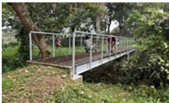
Foto 51. Adecuación Humedal Cañasgordas. Archivo CVC, 2024
