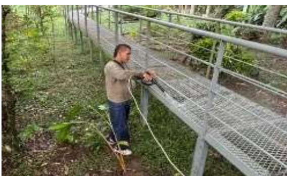
Foto 52. Adecuación Eco parque Lago Las Garzas. Archivo CVC, 2024
