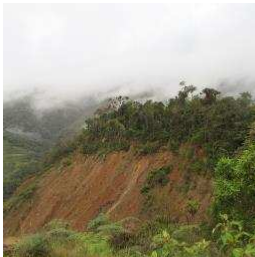
Foto 15. Derrumbe. El Placer
