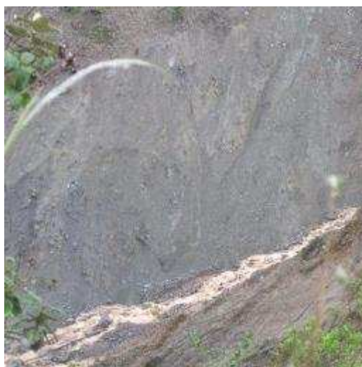
Foto 16. Deslizamiento. El Placer
