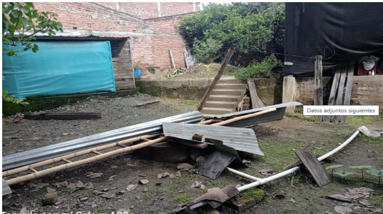
Foto No. 2. Ubicación del aljibe, con instalación eléctrica y tubería de conducción.
