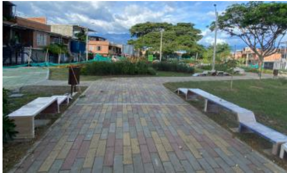
Foto 106. Adecuación de sendero. Archivo CVC, 2025
