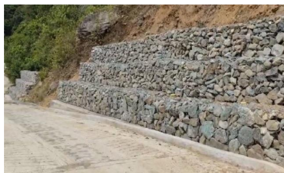
Foto 105. Construcción de gaviones para mitigación del riesgo por deslizamientos en el Municipio de Bolívar. Archivo CVC, 2025
