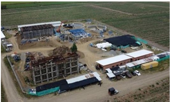
Foto 76. Construcción de la PTAR de la cabecera municipal de Zarzal. Archivo CVC, 2025.
