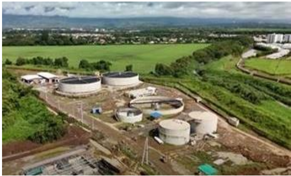
Foto 73. Construcción de la PTAR de la cabecera municipal de Jamundí. Archivo CVC, 2025.
