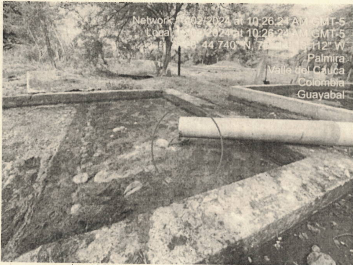
Imagen 3: Sistema de tratamiento, Desarenadores y Trampa de grasas
