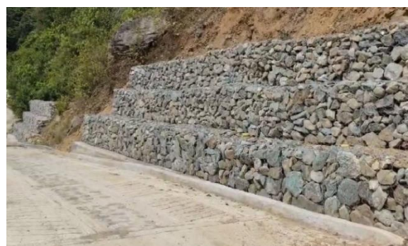
Foto 149. Construcción de gaviones para mitigación del riesgo por deslizamientos en el Municipio de Bolívar. Archivo CVC, 2025
