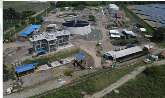
Foto 113. Construcción de la PTAR corregimientos El Carmelo, San Joaquín, Villagorgona y Buchitolo en el municipio de Candelaria. Archivo CVC, 2025.
