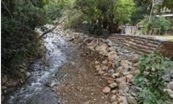
Foto 8. Implementación de la estrategia de Mitigación del deslizamiento del suelo, en taludes de la Quebrada El Cogollo-cuenca Dagua. Archivo CVC. 2025
