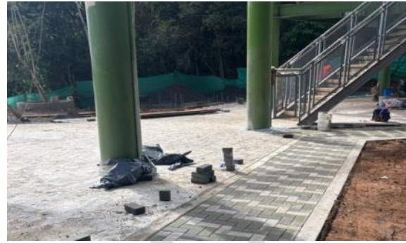
Foto 97. Sendero perimetral en deck. Archivo CVC 2025
