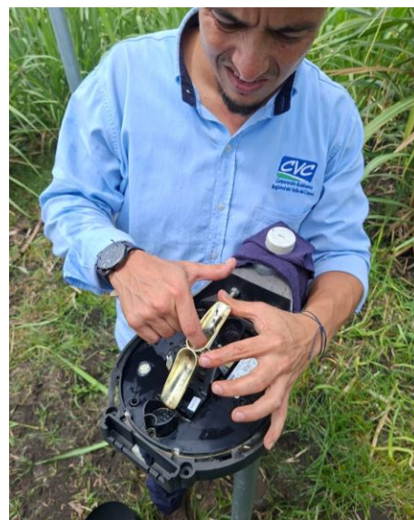
Foto 6. Mantenimiento de estaciones de monitoreo de suelos automatizadas (Detalle 2). Archivo CVC, 2025.
