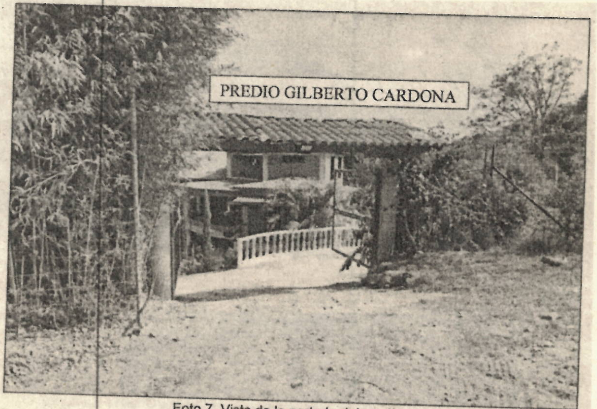
Foto 7. Vista de la portada del predio.
