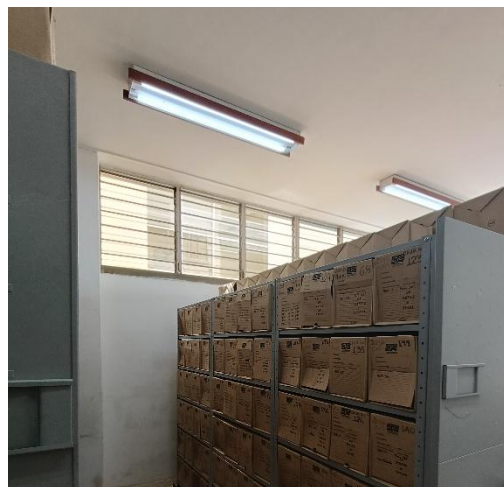
Fotografía 17. Iluminación Archivo Central Soportes Contables
