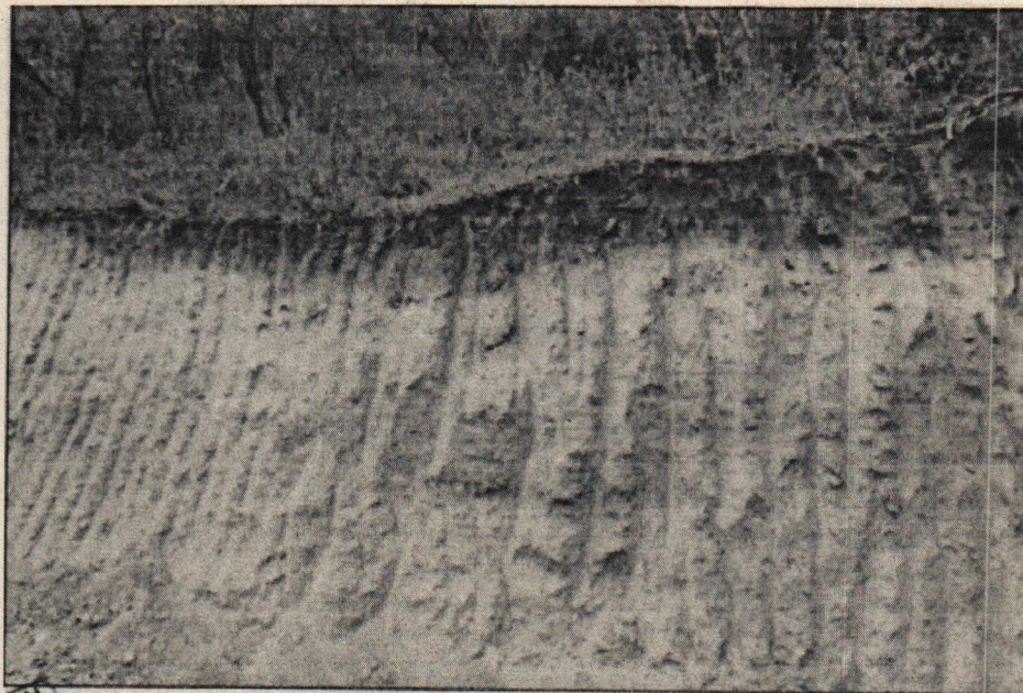
Foto 3. Corte de talud
