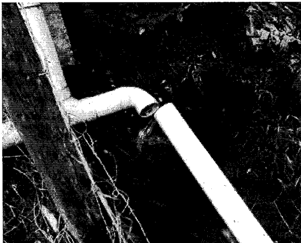
Ilustración 10. TUBERÍA DESPEGADA AL MOMENTO DE LA VISITA CON DERRAME DE RESIDUO DE PRODUCCIÓN PORCÍCOLA. DANIEL H. CVC 2026.
