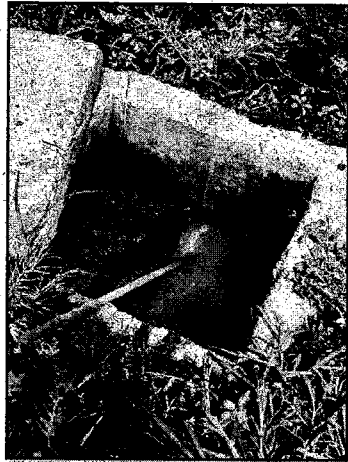
Imagen 7. Tubería que conduce las ARnD
