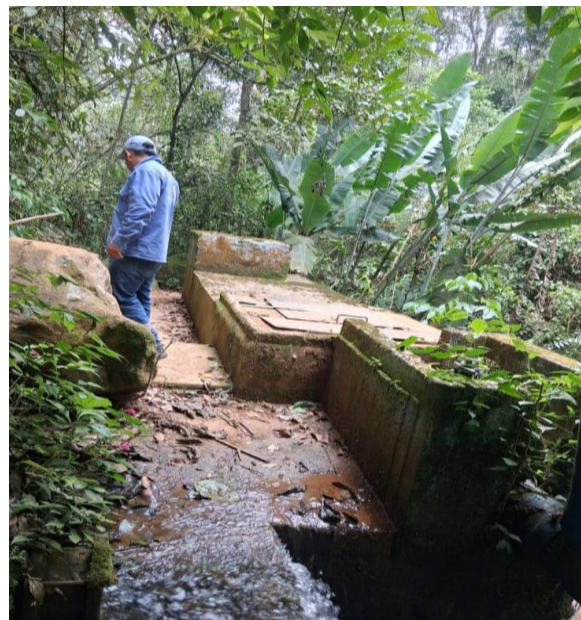
Planta de Tratamiento de Agua Potable –PTAP (Cuentan con 3 tanques de almacenamiento: 2 tanques de 131 metros cúbicos y uno de 211 metros cúbicos) (Coordenadas geográficas: 3.502746N; -76.561320W)
