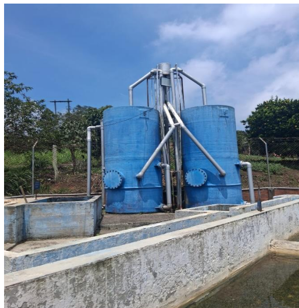
Planta de Tratamiento de Agua Potable –PTAP (Capacidad del tanque de almacenamiento 180 metros cúbicos) (Coordenadas geográficas: 3.511632N; -76.557670W)
