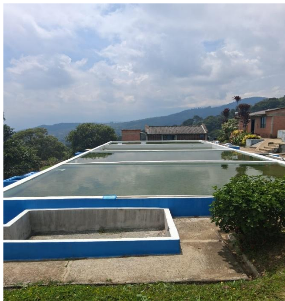
Planta de Tratamiento de Agua Potable –PTAP (Capacidad del tanque de almacenamiento 180 metros cúbicos) (Coordenadas geográficas: 3.511632N; -76.557670W)
