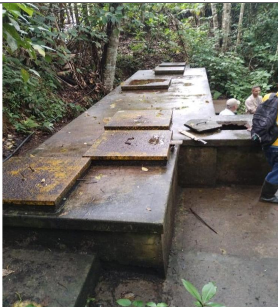
Tanque Desarenador (Coordenadas geográficas: 3.512678N; -76.577063W)
