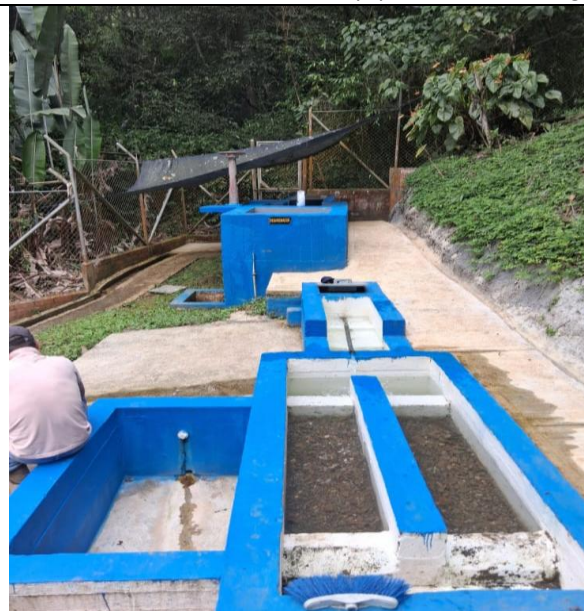
Planta de Tratamiento de Agua Potable –PTAP (Capacidad del tanque de almacenamiento 18 metros cúbicos) (Coordenadas geográficas: 3.510977N; -76.576599W)
