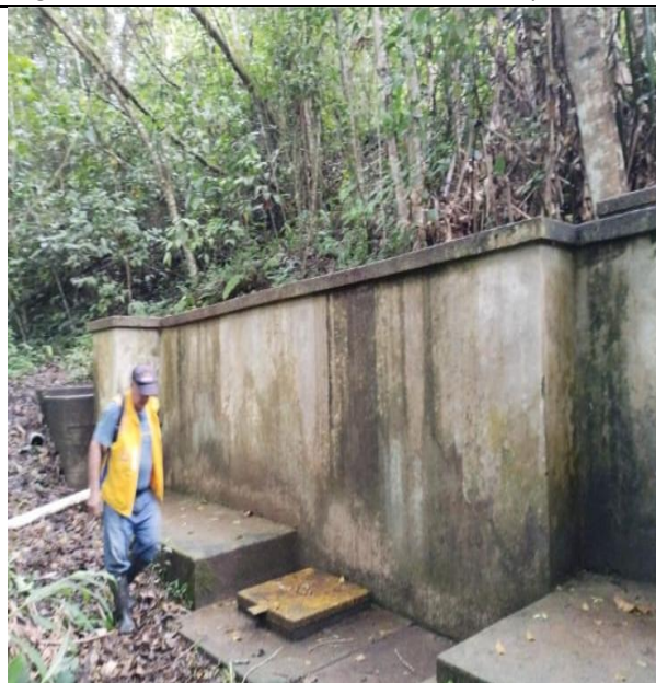
Tanque Desarenador (Coordenadas geográficas: 3.512678N; -76.577063W)
