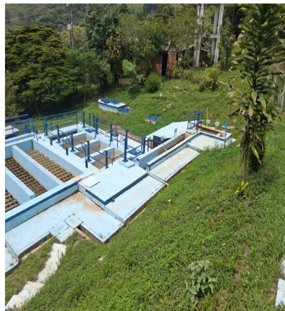
Planta de Tratamiento de Agua Potable –PTAP (Cuentan con 3 tanques de almacenamiento: 2 tanques de 131 metros cúbicos y uno de 211 metros cúbicos) (Coordenadas geográficas: 3.502746N; -76.561320W)
