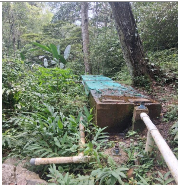
Tanque Desarenador Captación Q. El Chocho (Coordenadas geográficas: 3.503430N; -76.565258W)
