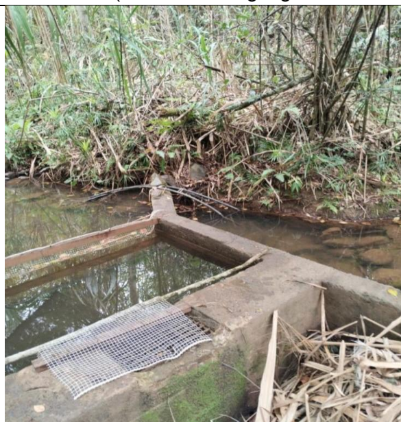
Captación Quebrada La Soledad (Coordenadas geográficas: 3.493379N; -76.561980W)
