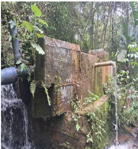
Planta de Tratamiento de Agua Potable –PTAP (Cuentan con 3 tanques de almacenamiento: 2 tanques de 131 metros cúbicos y uno de 211 metros cúbicos) (Coordenadas geográficas: 3.502746N; -76.561320W)
