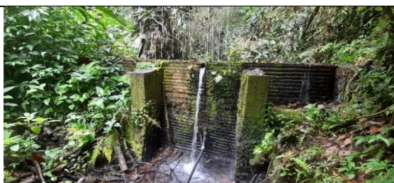
Obra de represamiento aguas abajo nacimiento Los Chorros
