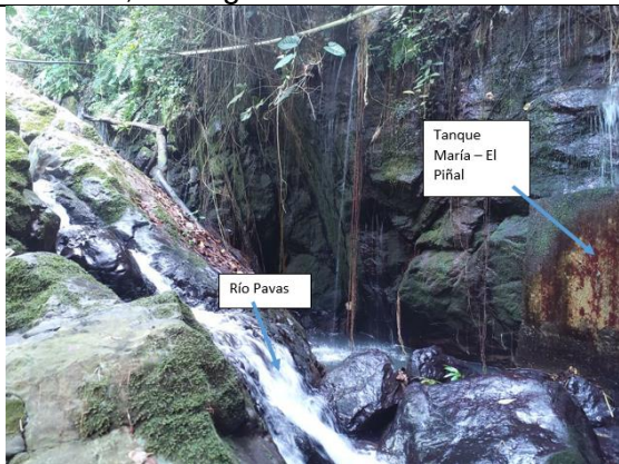
Acueducto María – El Piñal – Confluencia con el río Pavas
