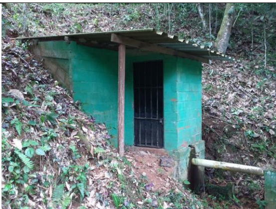
Acueducto de Párraga – Nacimiento, Punto de captación
