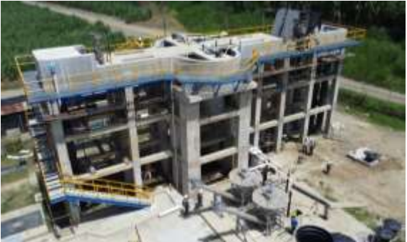
Foto 118. Construcción de la PTAR de la cabecera municipal de Zarzal. Archivo CVC, 2026
