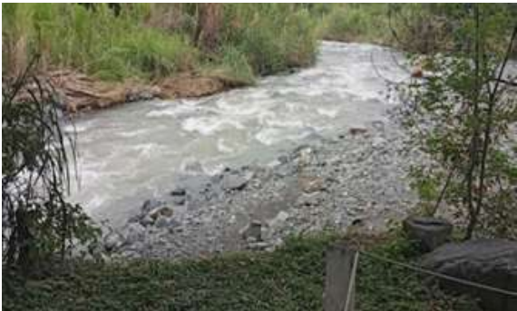
Foto 154. Cauce colmatado quebrada La Magdalena, Municipio de Guacarí. Archivo CVC, 2026
