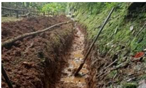
Foto 9. Reconformación de cuneta en tierra para manejo del agua de escorrentía. Archivo CVC, 2026
