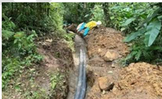
Foto 10. Adecuación del canal de derivación de la Quebrada Los Indios. Archivo CVC, 2026
