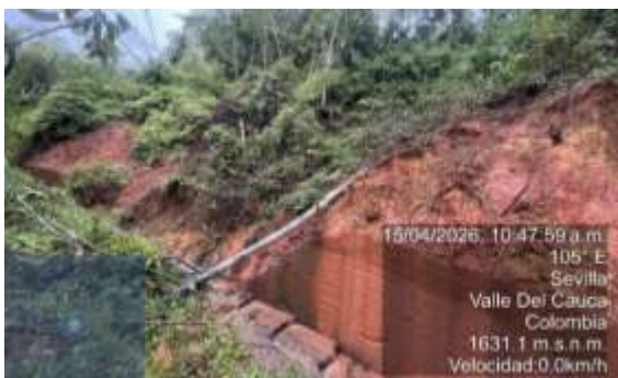
Foto 146. Recorrido por la zona afectada por movimiento en masa activo, quebrada San José, municipio Sevilla. Archivo CVC, 2026
