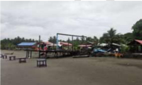
Foto 148. Afectación de viviendas por la erosión en La Barra. Archivo CVC, 2025.
