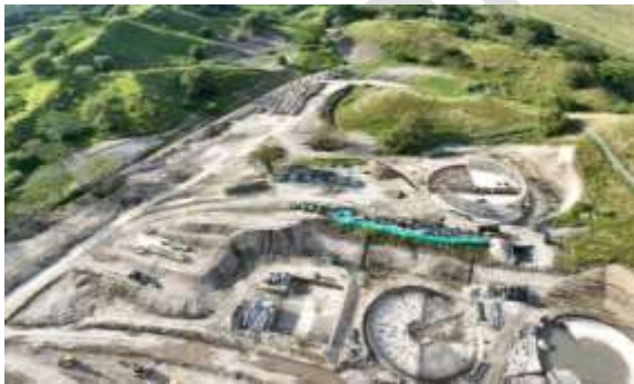
Foto 114. Construcción de la PTAR de la cabecera municipal de Cartago. Archivo CVC, 2026
