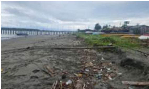
Foto 147. ) Escarpes erosivos en Juanchaco. Archivo CVC, 2026
