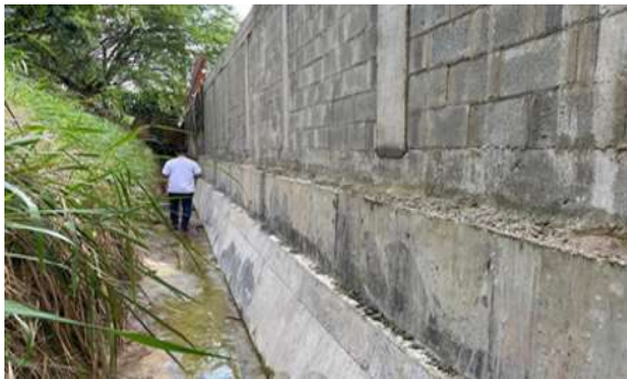
Foto 184. Construcción de canal Santa Mónica. Archivo CVC 2026.
