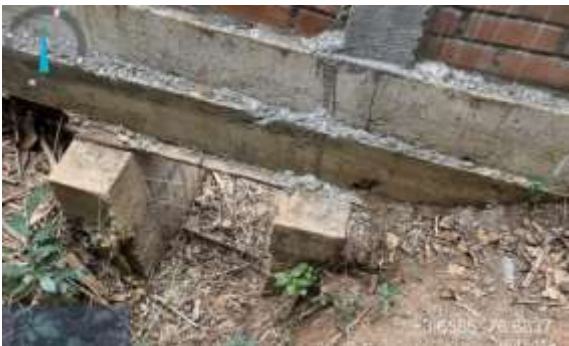
Foto 198. Detalle cimentación del cerramiento del parqueadero de la DAR Pacífico Este. Archivo CVC, 2026.
