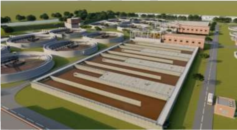
Ilustración 10. Diseños del Tratamiento Secundario de la Planta de Tratamiento de Aguas Residuales - PTAR Cañaveralejo de Cali. Fuente: Consultoría Hazen & Sawyer Colombia, 2026. Archivo CVC, 2026
