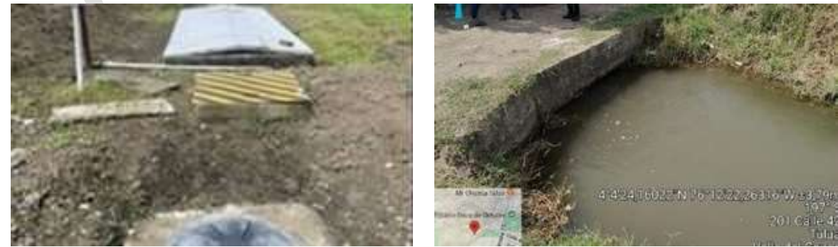
Foto 141. Evaluación permiso de vertimientos, Sistema de tratamiento de aguas residuales domésticas predio Granja Santa Cecilia, Corregimiento de Zaragoza - Cartago. Harold Adrián Sánchez. Archivo CVC 2026 Foto 142. Evaluación ocupación de cauce, Lote de Terreno 17, Moreno Tafurt - Tuluá. Alexander Gómez. Archivo CVC 2026.
