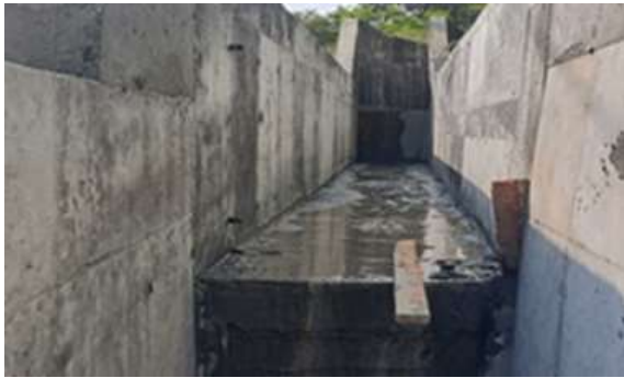
Foto 181. Cara interior del canal Chipichape. Archivo CVC 2026
