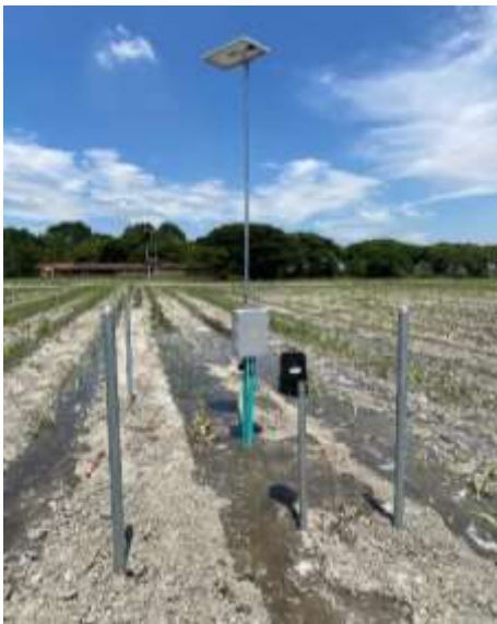
Foto 5. Estaciones automáticas de calidad del suelo instaladas. Archivo CVC, 2026
