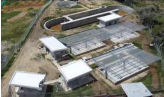
Foto 117. Construcción de la PTAR de la cabecera municipal de El Dovio. Archivo CVC, 2026
