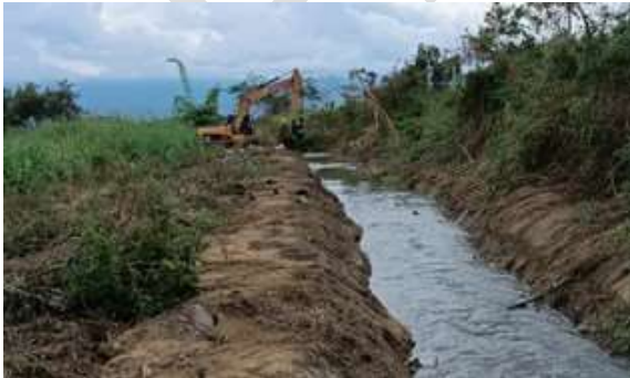
Foto 143. Seguimiento y control, requerimientos de descolmatación Acequia Nariño – Tuluá. Luis Hernando Escobar. Archivo CVC 2026
