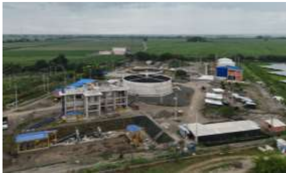
Foto 115. Construcción de la PTAR corregimientos El Carmelo, San Joaquín, Villagorgona y Buchitolo en el municipio de Candelaria. Archivo CVC, 2026
