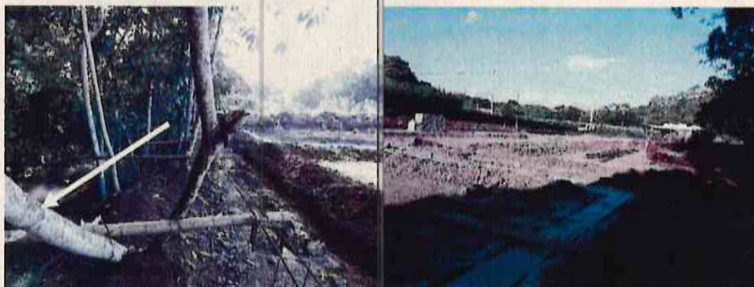
Imágenes 4 y 5. Vista general del área afectada, resaltando la cercanía, menos de cinco metros, de la quebrada Zaija, donde se intervino con equipo pesado (maquinaria amarilla).
