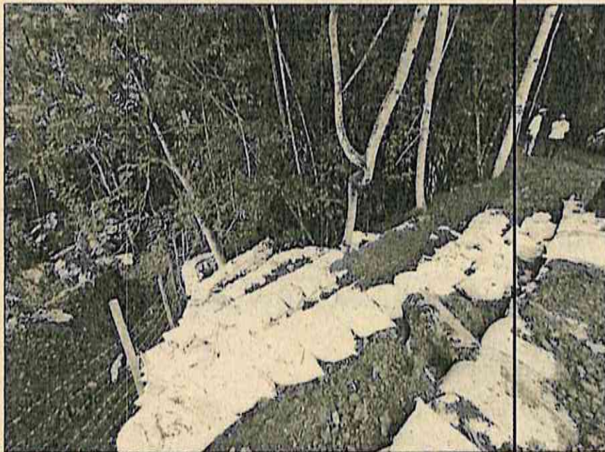
Fotografía 3. Vista general de las seis terrazas a conformar con sacos de arena en la parte inferior del predio.
