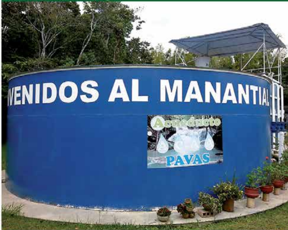
Embalse de almacenamiento de agua
